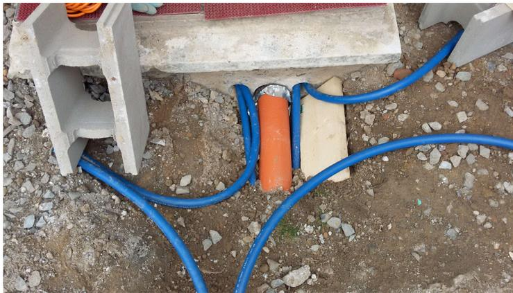
Konvektionsrohre für die Luft-/Wasser-Kühlung
